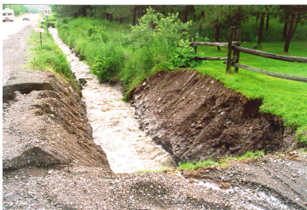
Photographie no 2 : Début de section nettoyée selon la méthode traditionnelle pour les premiers mètres, puis selon la méthode du tiers inférieur pour le reste. La photographie a été prise lors de la période de fortes précipitations de la mi-juillet 1996 et moins d'une semaine après l'intervention de nettoyage du fossé. Remarquer la forte érosion déjà en place dans les premiers mètres alors que la partie creusée selon la méthode du tiers inférieur est demeurée presque intacte. (Route 222-01-120, vue vers le sud-est) (Photo RAPPEL, 96-07-12)
